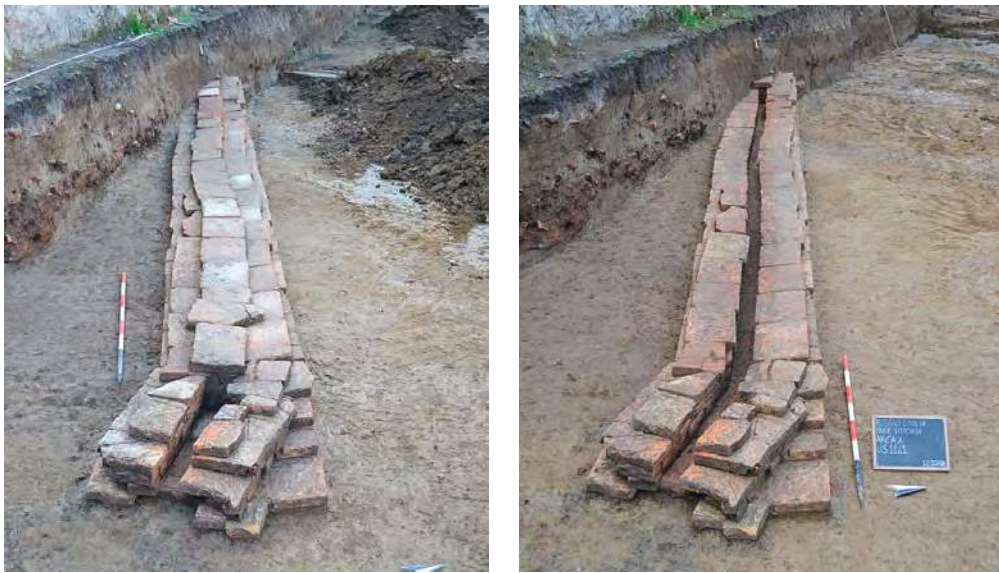
Fig. 5. La condotta fognaria di delimitazione della domus in due diversi momenti di scavo.
